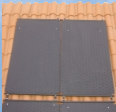
Ejemplo de instalación y conexionado de captadores ROTHPOOL®
